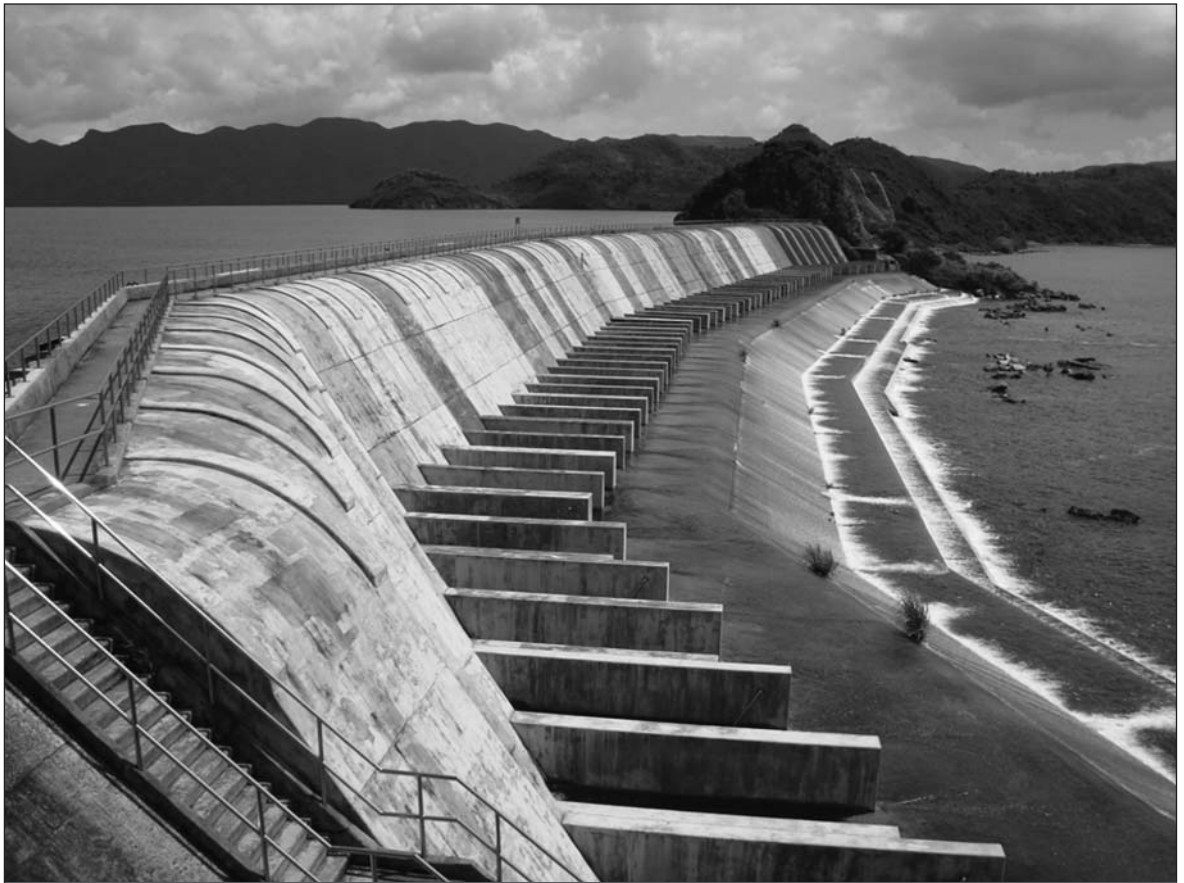
Fig. 14. Plover Cove spillway
