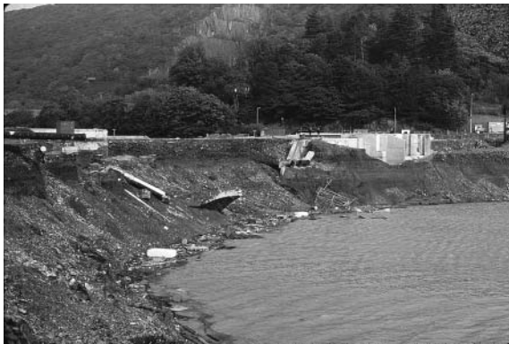
Fig. 29. Llyn Peris failure
